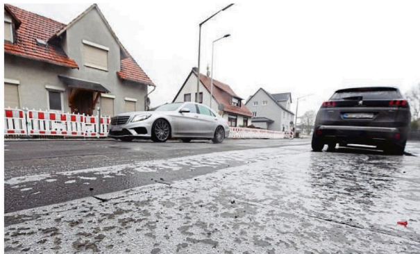
Kein gefahrloses Durchkommen: Auch für Fußgänger, etwa Schulkinder, war es gestern Morgen ohne Gefahr nicht möglich, unterwegs zu sein. Hier eine Situation in der Nürnberger Straße in Walldorf.
